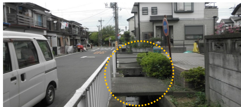
H29.8集中豪雨の際、水路が溢水したため、流れを阻害しないよう対策予定
