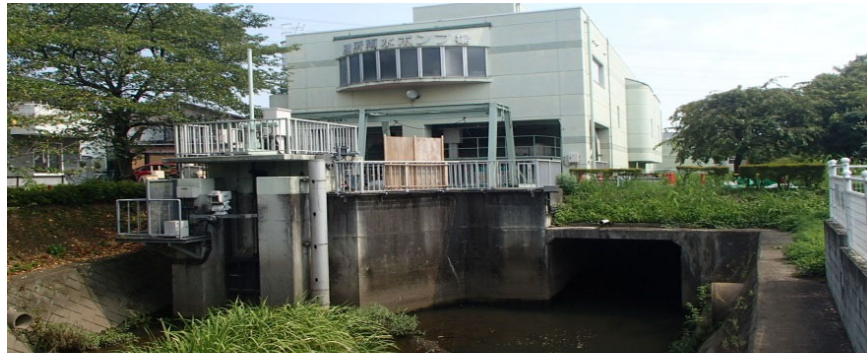
水子・水谷東地域の雨水を新河岸川へ放流
