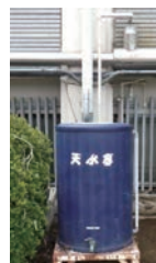
雨水貯留施設(雨水タンク)の例
