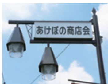
久保田さんが中心となり、地域の防犯のために平成26年度に商店街の街路灯をLED化した。
