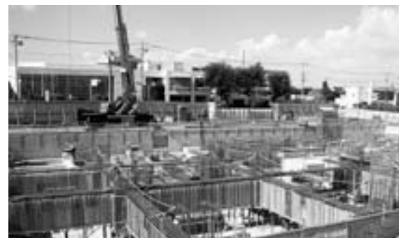
着々と工事の進む消防本部・消防署庁舎(9月撮影)
