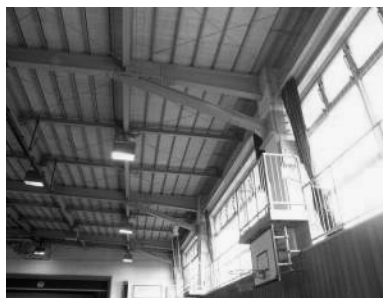
みずほ台小学校体育館の耐震補強工事が完了しました
