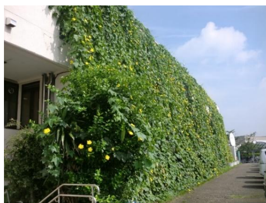
庁舎の壁面緑化
