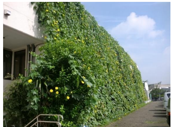
庁舎の壁面緑化
