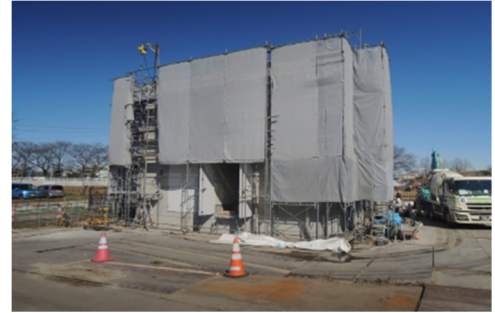
改修中の図川排水機場
