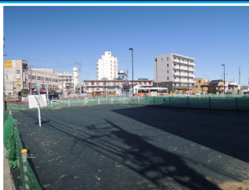
鶴瀬駅東口駅前広場
