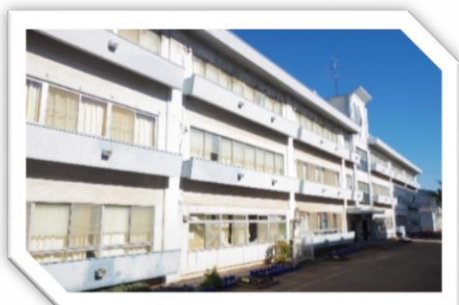
水谷小学校 北校舎
