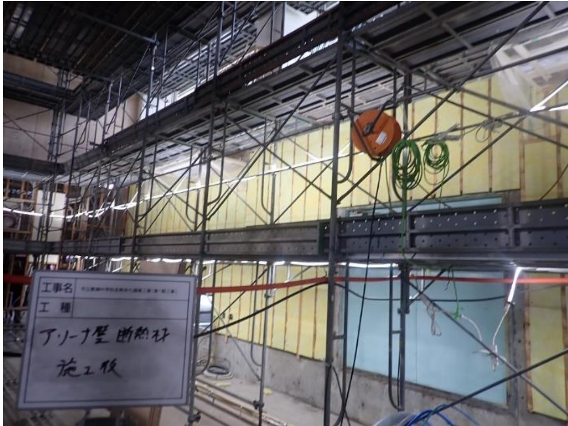
断熱材施工
