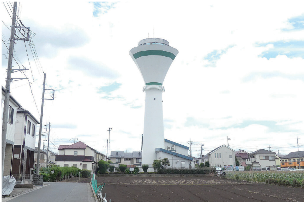
鶴瀬西配水場
