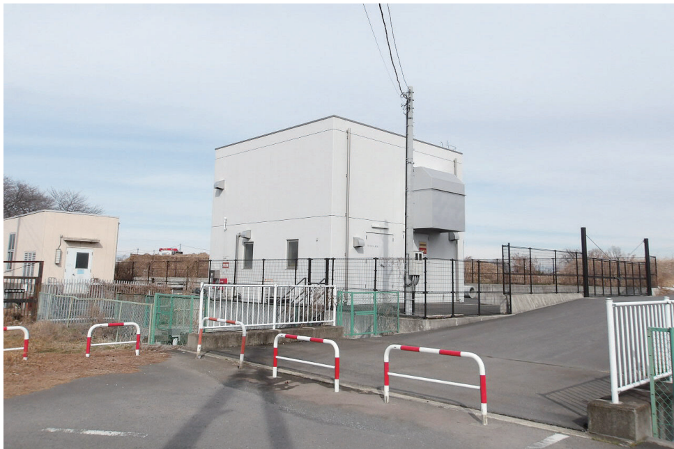
凶川排水機場
