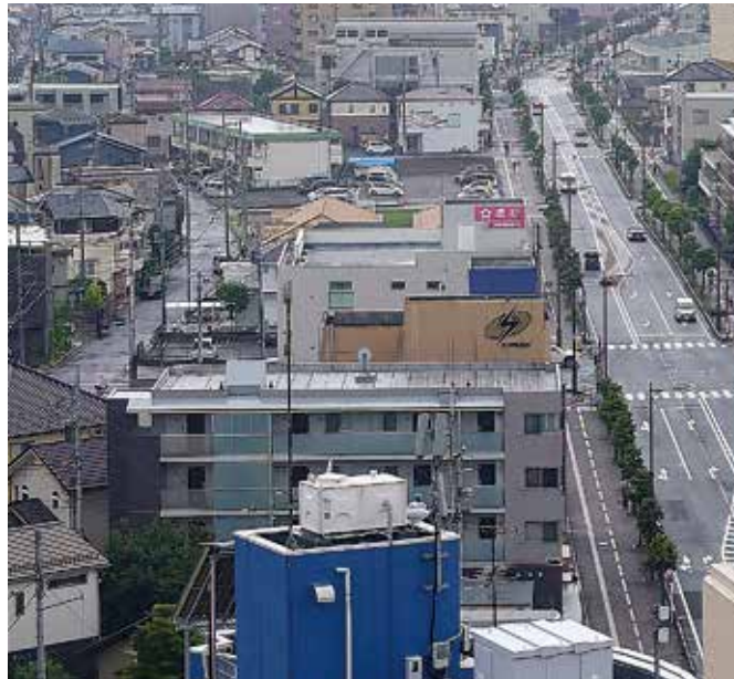
鶴瀬駅西通り線の様子
