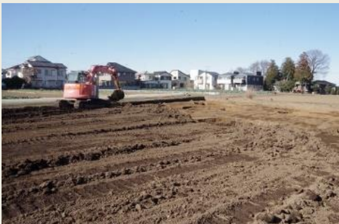
重機による埋め戻し作業の様子
