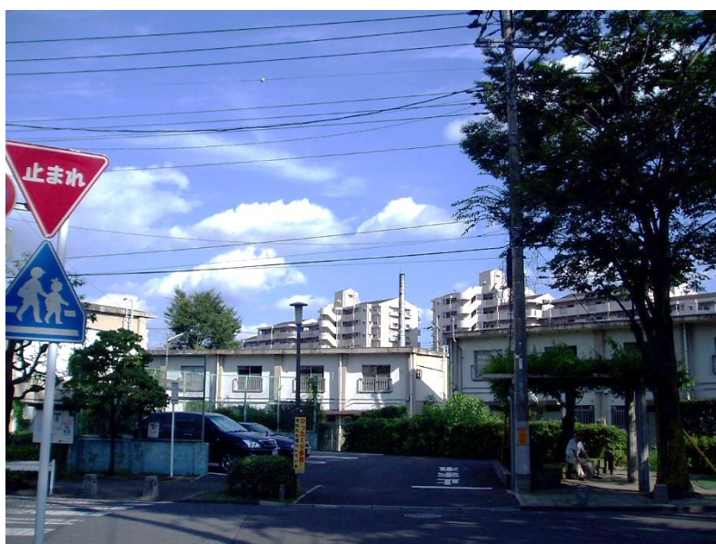
建替中の鶴瀬団地(手前住宅が建替前、奥建物が建替後)
