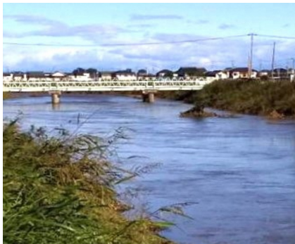
台風19号による増水 (南畑橋近く、2019年)
