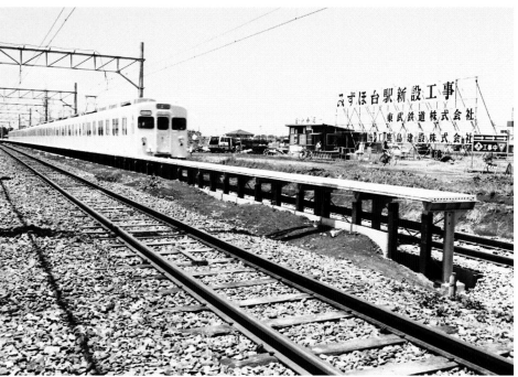
みずほ台駅新設工事 東武博物館所蔵
