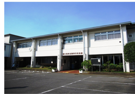
昭和56年5月新築開館
