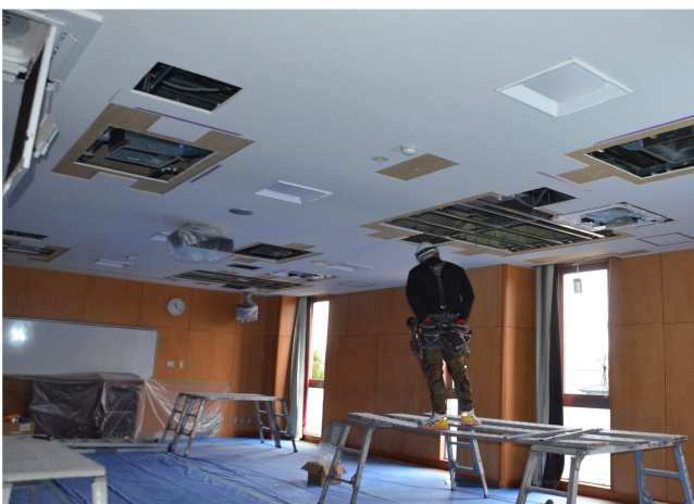
空調工事中の2階講座室
