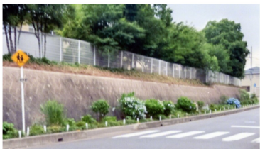
撤去後の外周
