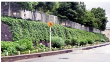
撤去する前の外周
