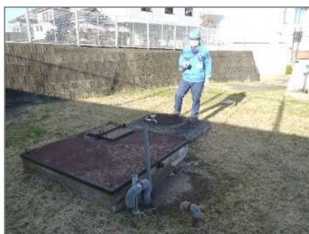
水源の巡回点検（外観）
