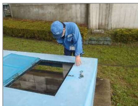
水源の巡回点検（内部）
