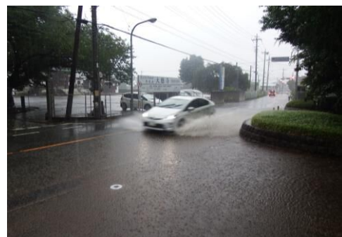
図 124 公園北側の市道の冠水状況
