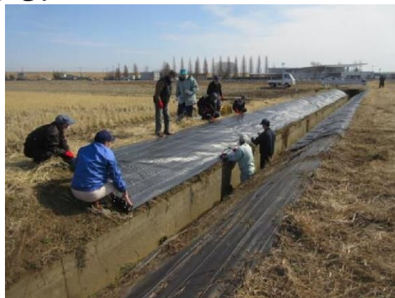
防草シートの設置
