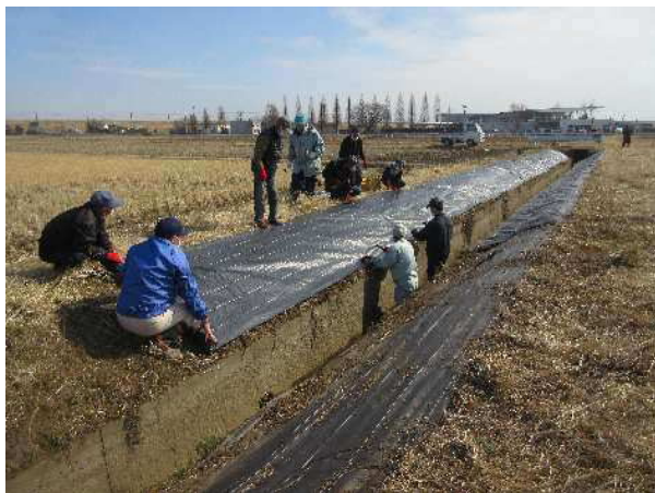
防草シート張り
