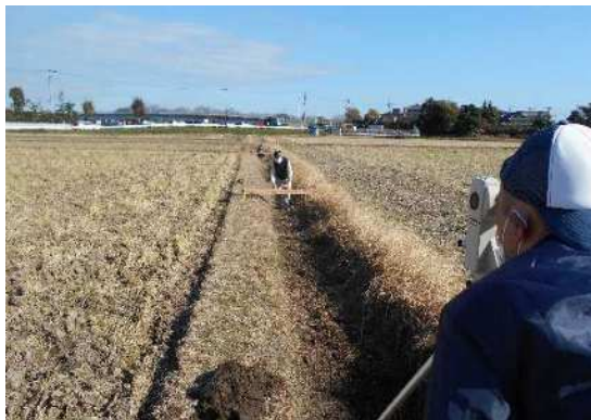
長寿命化対策工事に伴う測量作業
