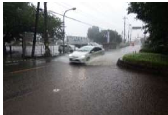
第 83 図 公園前の道路の冠水
