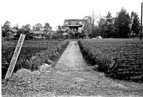
第3次調査の頃(昭和42年)の大応寺付近
